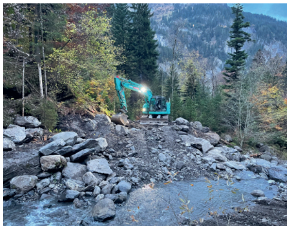
Sinsgäubach, Sanierung Ufersicherung Fellbodenwald
