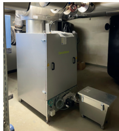
Neuer Feinstaubfilter
