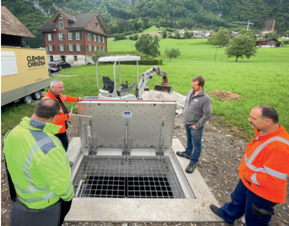
Regenüberlaufbecken Uechtern: Abnahme der Sanierung Einstieg
