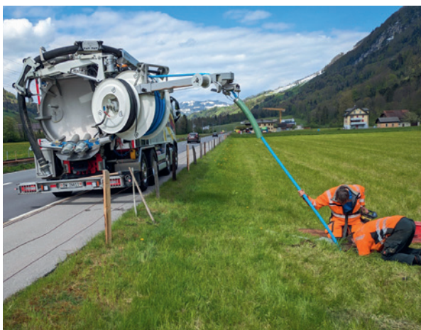
Spülen einer Kanalisation
