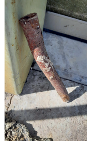
Stock in Kanalisation führte zu Verstopfung
