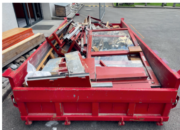
Die alten Fronten vom Dönni werden entsorgt.
