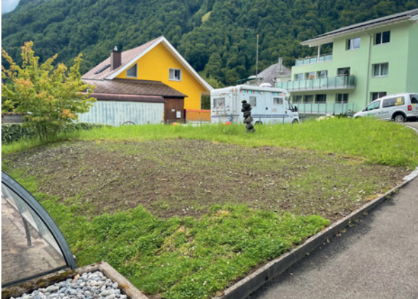
Rückbau des alten Pausenraums neben dem ORS-Schulhaus
